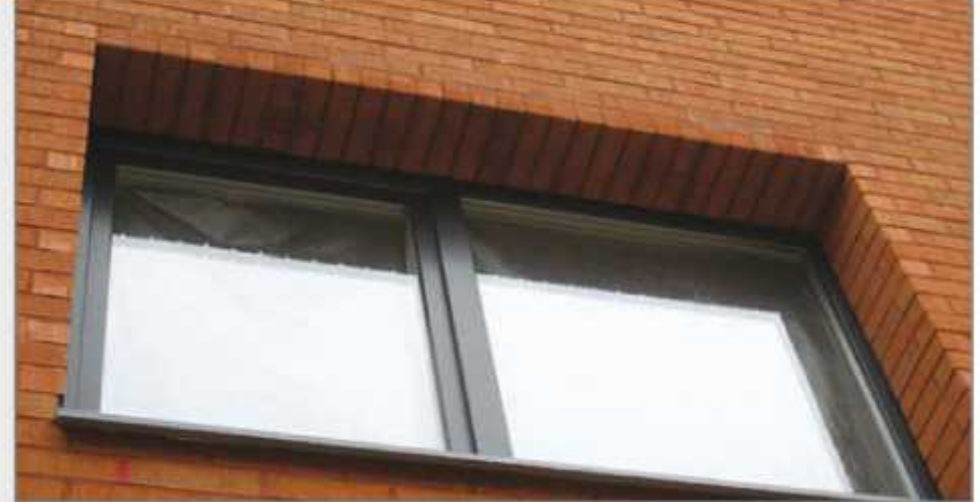
ВЕРТИКАЛЬНАЯ КЛАДКА В ПОЛТОРА КИРПИЧА
