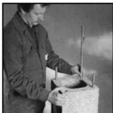
34. Вставьте арматурные стержни в специальные каналы. Упоры на арматурных стержнях с резьбой не позволят им провалиться внутрь. Количество стержней определяется проектом.
