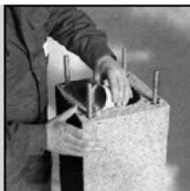
35. Залейте раствором каналы с установленными арматурными стержнями. Стержни в канале должны быть отцентрированы, чтобы раствор занял всё необходимое пространство.
