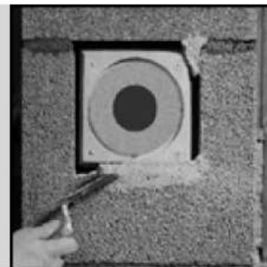
28. Заделайте раствором оставшиеся зазоры, следя за тем, чтобы раствор не попал во внутреннюю часть дымохода. Продолжайте монтаж в стандартной последовательности.
