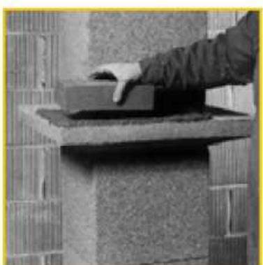
47. При обмуровке кирпичом верхней части дымохода, используется консольная плита. На неё устанавливаются каменные оболочки, а позднее вокруг выполняется кирпичная кладка.
