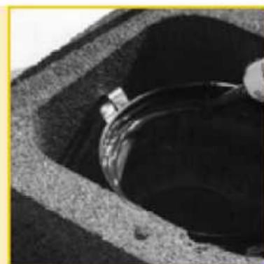
8. Нанесите на верхнюю кромку ёмкости для сбора и отвода конденсата достаточное количество герметика Rotempro. Температура монтажа должна быть  $\geq 5^{\circ}\text{C}$
