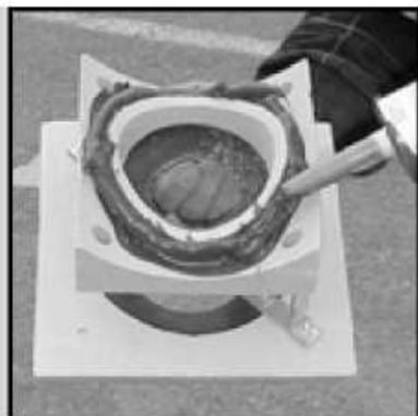
26. На внутреннюю часть элемента для подключения потребителя обильно нанесите герметик Rotempo.
