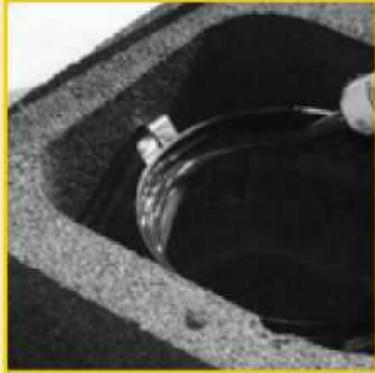
14. Обильно нанесите герметик Rotempro на верхнюю кромку керамической трубы.
