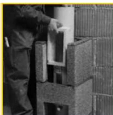
11. Установите внутрь тройник для подключения дверцы. На верхней грани любого керамического элемента выступ находится снаружи, канавка внутри. Ориентация т.н. «по воде» действует для всех видов топлива.
