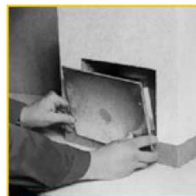
33. После затвердевания штукатурки закройте отверстие для отвода конденсата нижней заглушкой.
