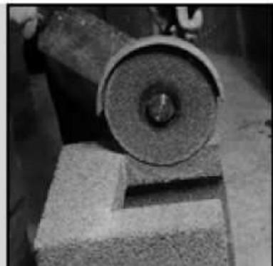
20. Угловой шлифовальной машиной вырежьте отверстие.
