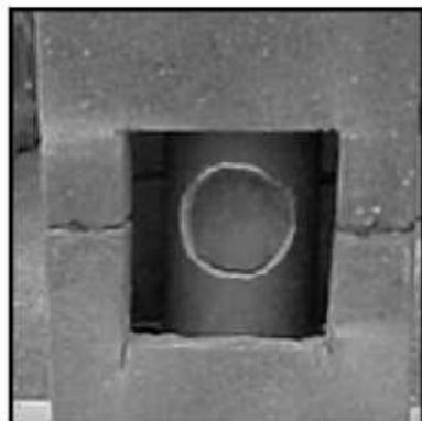
25. Вставьте керамическую трубу с готовым отверстием внутрь каменной оболочки. Последующие монтажные операции проводите в соответствии с указаниями рис. 13-18.
