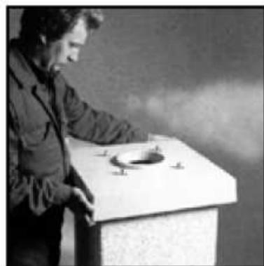
41. Положите покровную плиты проверьте уровнем.
