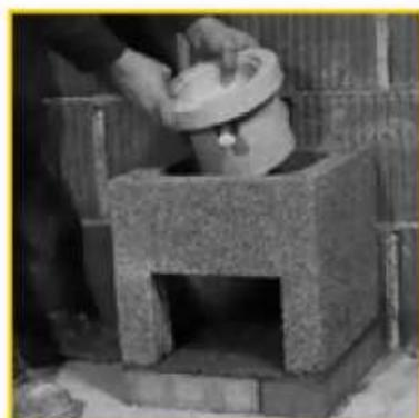
5. Установите ёмкость для сбора и отвода конденсата в центре блока. Трубопровод для отвода конденсата выведете в отверстие и подключите к системе канализации в соответствии с проектом.
