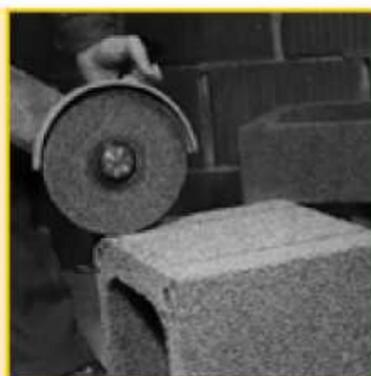
7. Угловой шлифовальной машиной вырежьте отверстие под дверцу.
