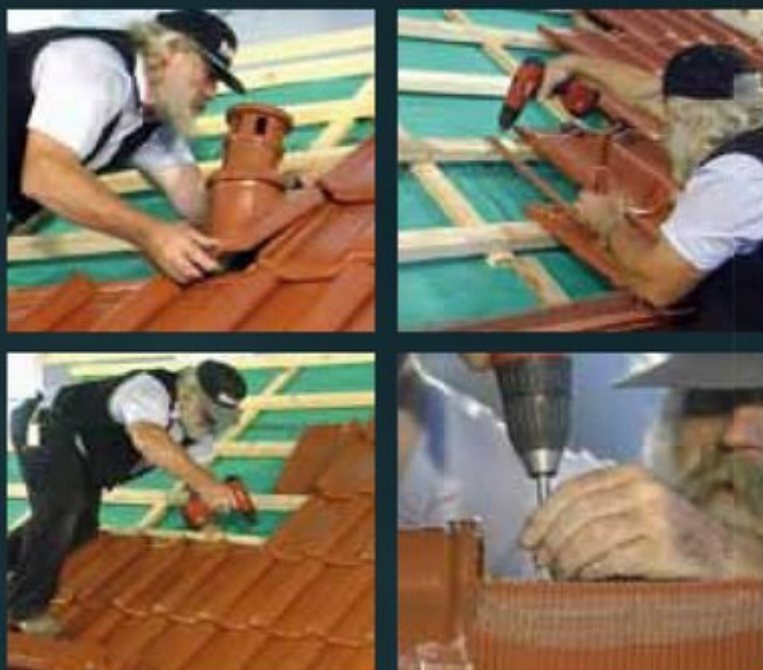
Ежи Птак во время укладки черепицы
