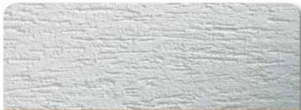
Штукатурка типа «Короед»
