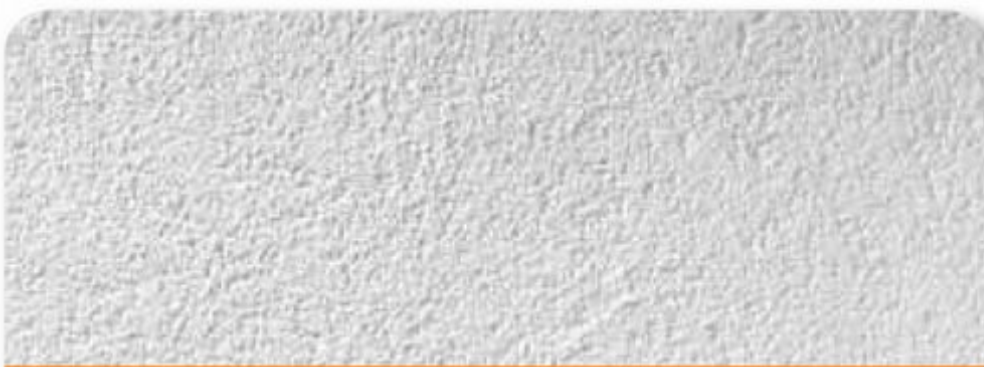
Штукатурка типа «Шуба»
